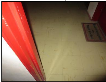
Photo N° 933 ECH-N°2 REVETEMENT DE SOL --PALIERS +3 Planchers Dalles de sol 30x30
